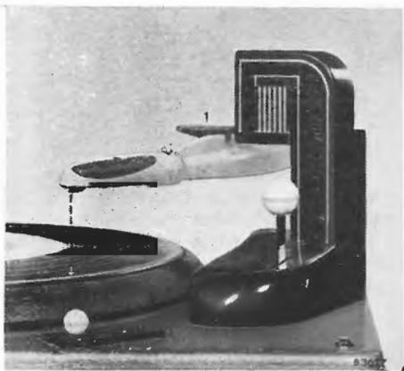
Fig. 54a. Dispositivo selezionatore del cambiadischi tipo AG 1004.
